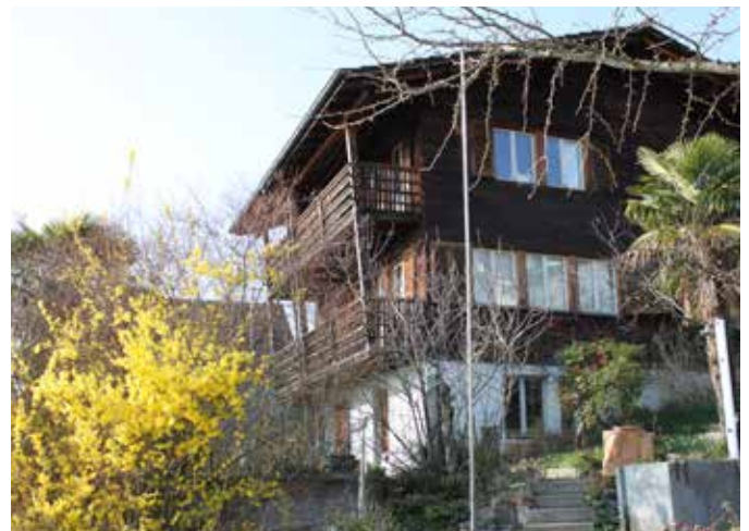
Bald wird das Chalet dem Neubau weichen
