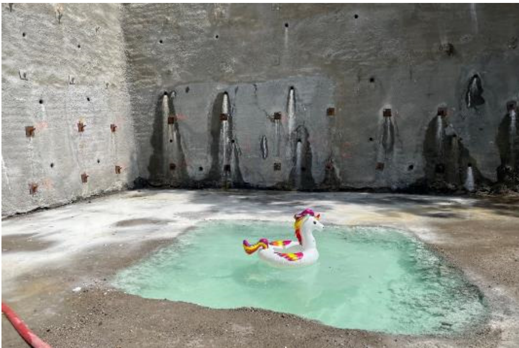
Unser Einhorn genießt den „Baugrubenpool“ ... ☺
